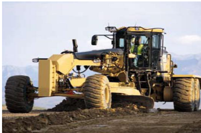
Figura 54. Motoniveladora tendiendo material (FUENTE: Manual de maquinaria Caterpillar para movimiento de tierras, O. P. y Minería).
