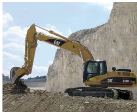
Figura 58. Excavadora en corte.
