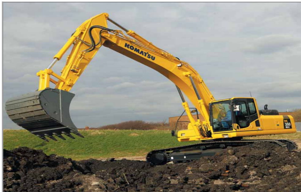
Figura 32.- Excavadora Komatsu Pc-350, tomada en Cantera por Gustavo Chiriboga
