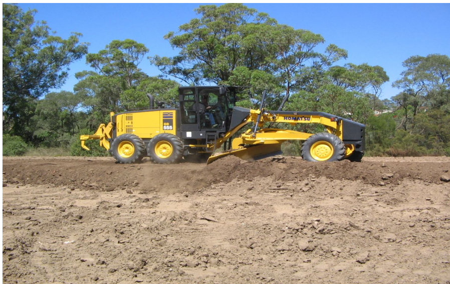
Figura 54.- Motoniveladora Komatsu GD-555 durante tendido de material, Catalogo Komatsu.
