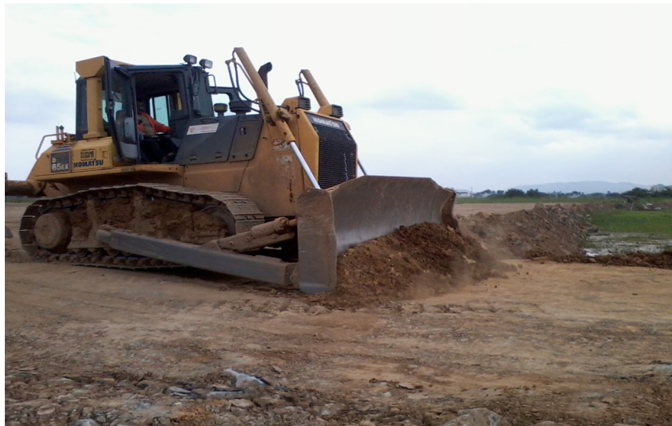
Figura 24.- tractor d-65, Tomada en obra por Gustavo Chiriboga
