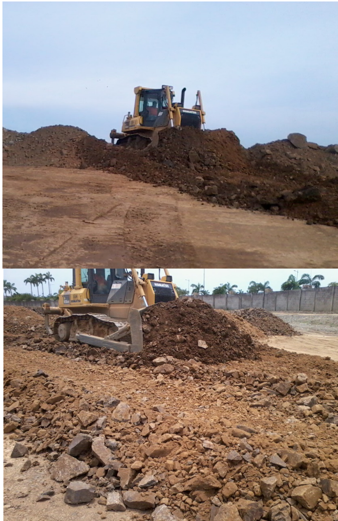
Figura 12.- Tractor D65 tendiendo material de relleno, tomada en obra por Manuel Rivera
