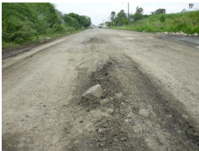
Gráfico 3.7. Estado Actual de la Estructura del Pavimento.
