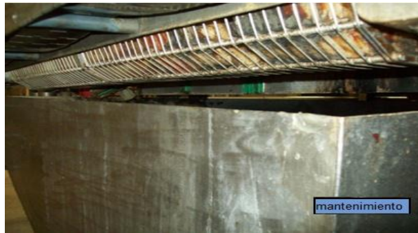
Fig.3.28. Mantenimiento de Túnel de enfriamiento
