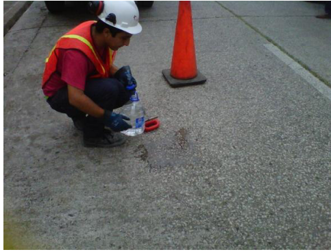
Limpieza con Agua sobre la superficie
