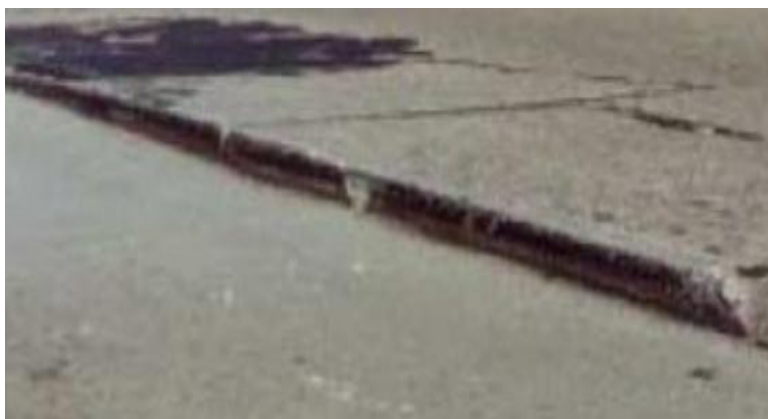
Figura 37: Dislocamiento de losa 46
