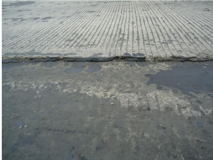
Figura 35: Levantamiento de losa 44
