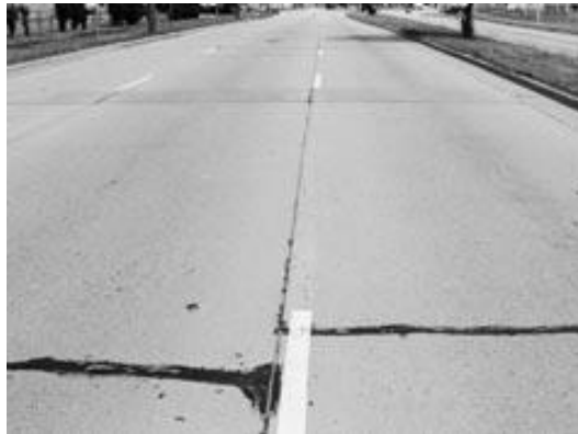
Pavimentos juntas más abiertas 81
