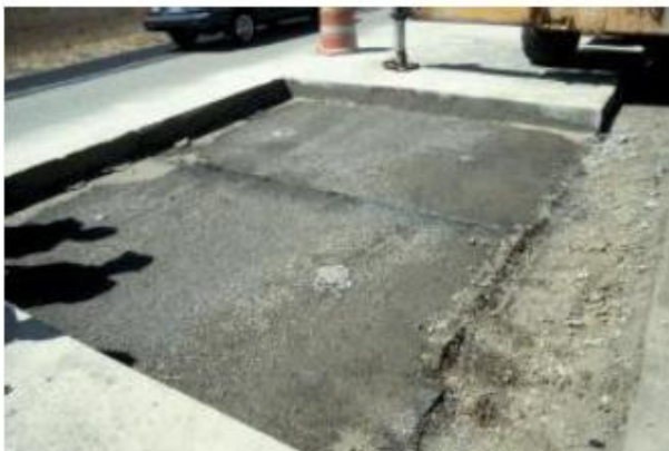
Figura 44: Preparación de la superficie para colocación de losa 53
