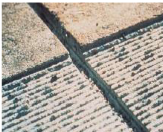
Figura 40: Cepillado en la superficie de la losa 49
