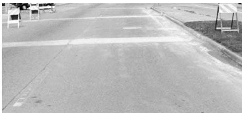
Superficie del Pavimento en excelentes condiciones 78
