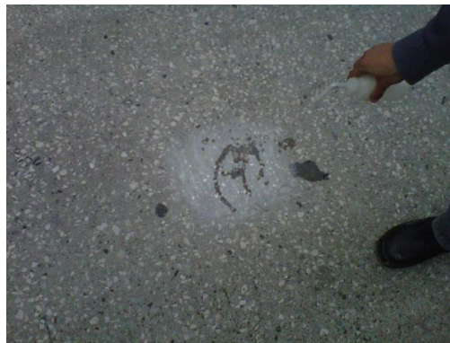
Colocación de Fenolftaleína en la superficie
