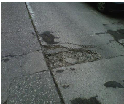
Figura 34: Descascaramiento 43
