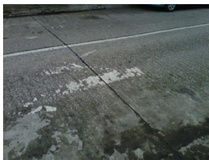
Figura 30: Pulimiento de losa de concreto 38
