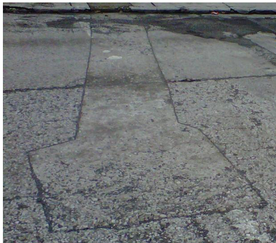
Figura 31: Parche de Hormigón Hidráulico 39
