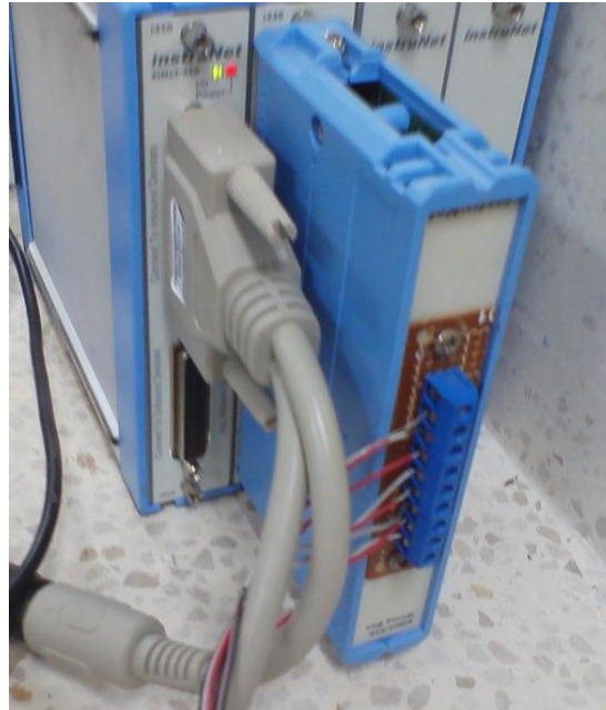
Figura 48. Conexión de las campanas de presión.
