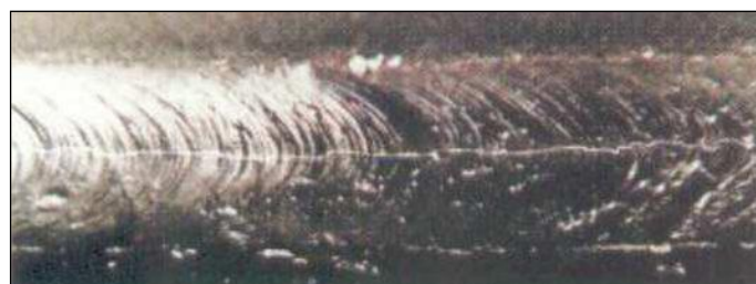
FIGURA 4.7.- FISURA DE GARGANTA Y DE RAÍZ
