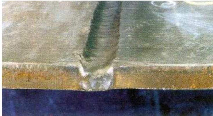
FIGURA 4.14.- SOCAVACIÓN EN CORDÓN DE SOLDADURA DE BISEL
