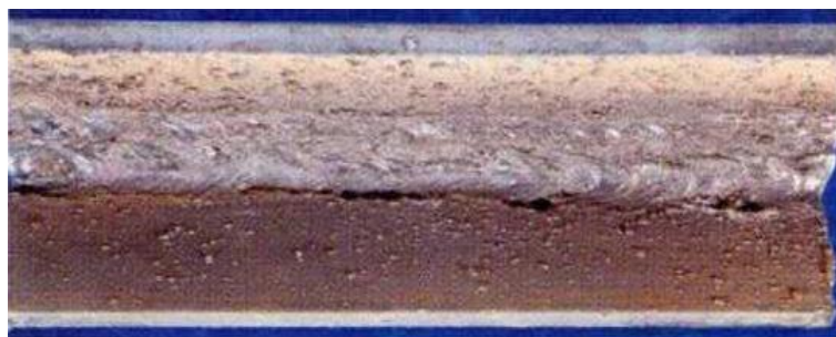
FIGURA 4.13.- SOCAVADURA ADYACENTE A SOLDADURA DE BISEL
