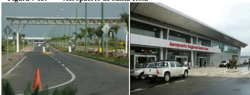
Figura # 15. Aeropuerto de Santa Rosa
