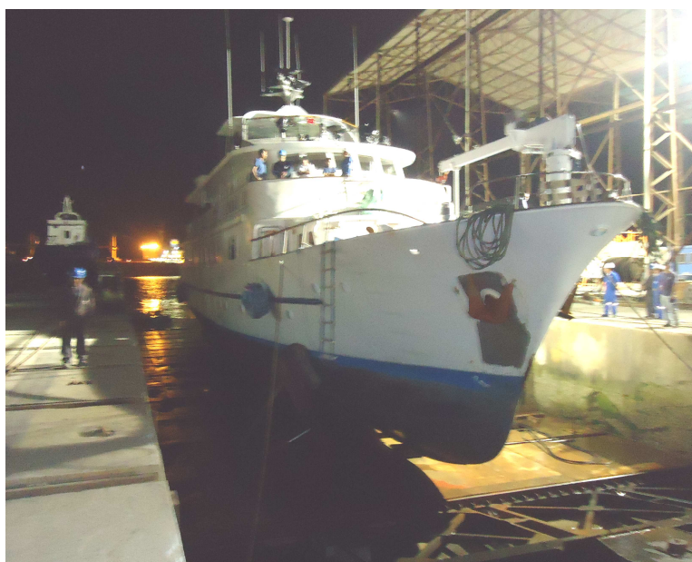
Figura N°32: Yate Coral 2, varado utilizando los brazos hidráulicos de proa ya instalados.
