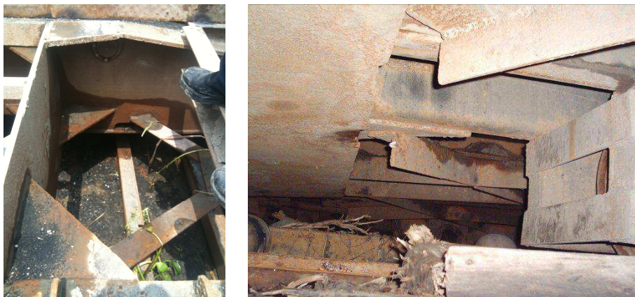
Figura N°26: Estructura de amarre adicionada (cruceas).
