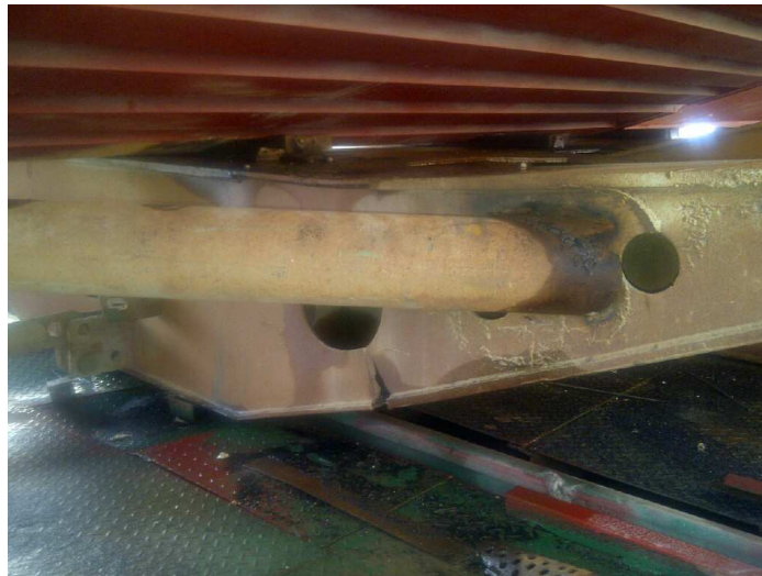
Figura N° 16: Daño en carro de transferencia nuevo.
