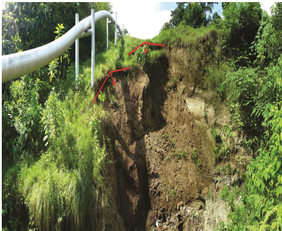
Foto 10 Escarpes activos de deslizamientos y desmoronamiento del margen fluvial provocando inestabilidad para los soportes de la tubería del poliducto. En la parte inferior se observa el cauce del estero Inés.
