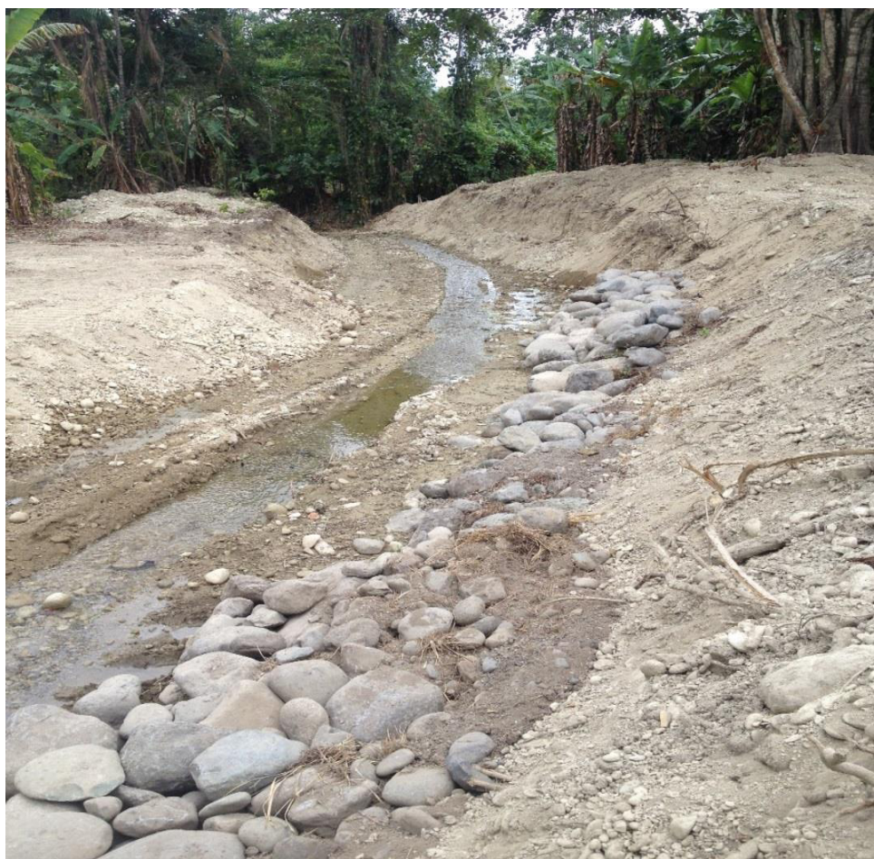
Foto 6 Ampliación de paredes para controlar el cauce del río (apilamiento de rocas y tierra) y evitar la erosión en el margen fluvial
