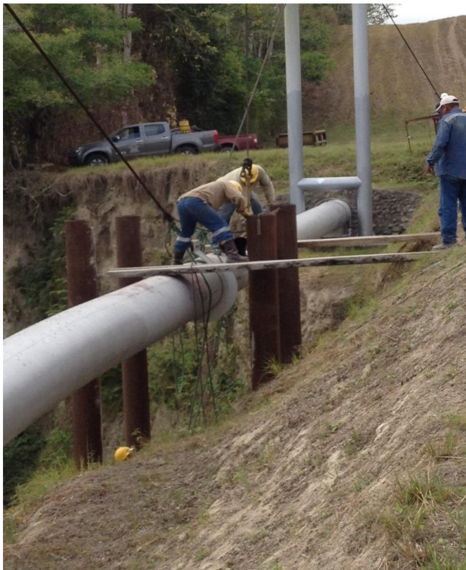
Foto 5 El punto PK-12 donde se están construyendo un soporte de fortalecimiento para la tubería.
