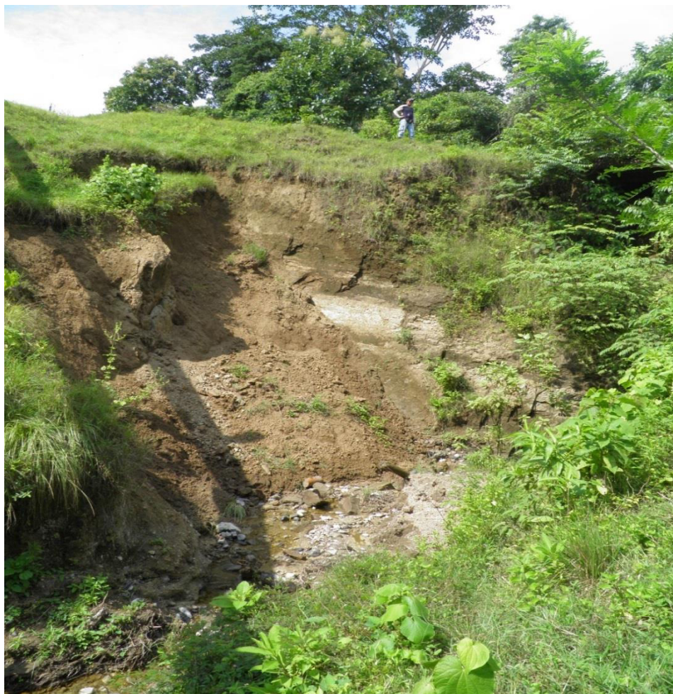
Foto 2 Deslizamientos superficiales y desmoronamiento de estratos en el marcador kilométrico PK 6+920.
