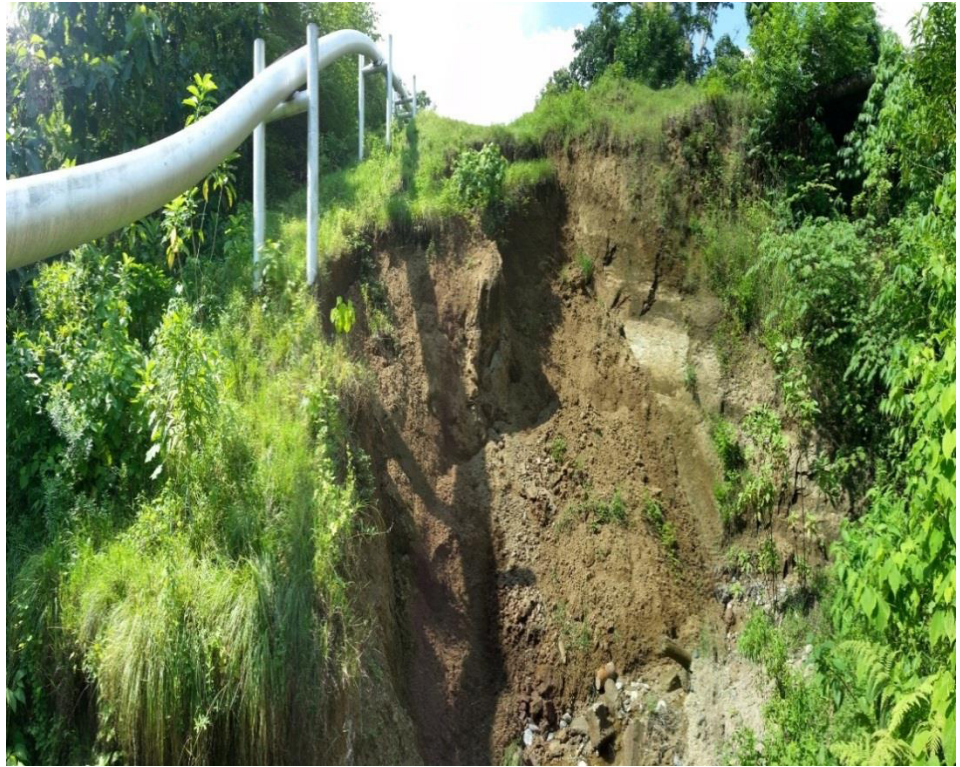
Foto 1 Vista panorámica de tubería que esta sobre el Pk-6+920.
