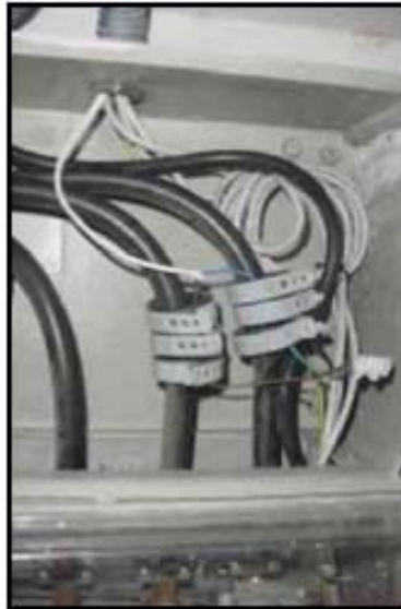
Figura 3-25 Acople inductivo para baja tensión [36]
