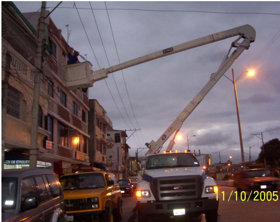
Figura 5-6 Instalación del equipo repetidor junto al transformador reductor [37]
