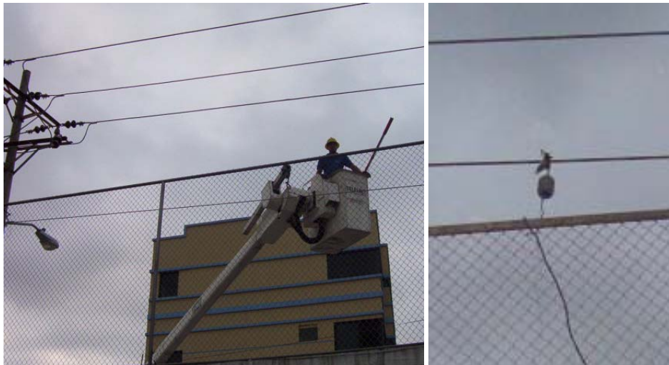
Figura 5-5 : Instalación del acople capacitivo sobre la red de media tensión (izquierda). Acople capacitivo ya instalado (derecha) [37].
