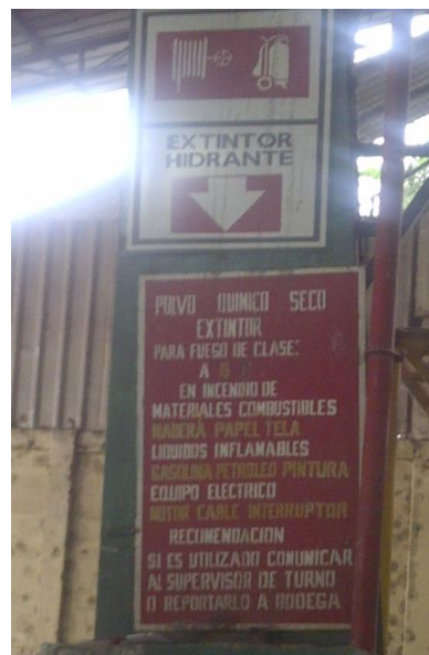
FIGURA 3.3 EXTINTOR DE HIDRANTE
