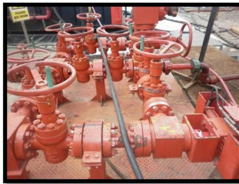
Figura 1.29 Choke Manifold (FUENTE: imagen tomada RIG Empresa DYGOIL)
