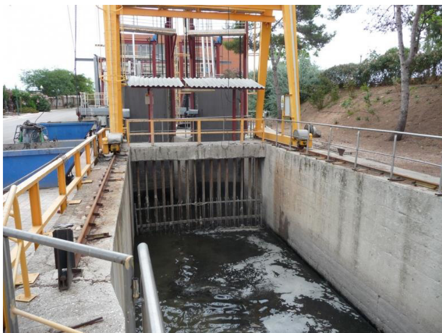
Figura 6. Rejas y tamices en acción (EMSHI, 2014)
