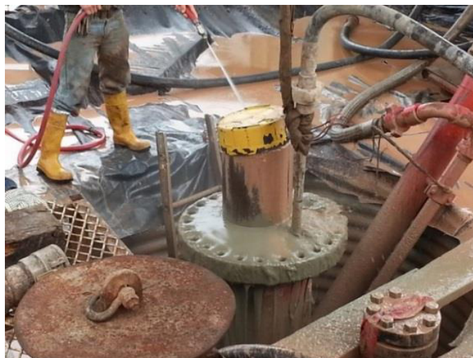
Figura # 58. Retorno de lechada de cemento por el espacio anular, pozo O-1i.
