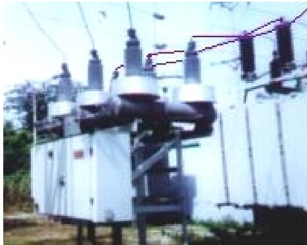
**Figura 3.43:** Barras que van del interruptor SF<sub>6</sub> a los pararrayos del lado de 69 Kv del transformador
