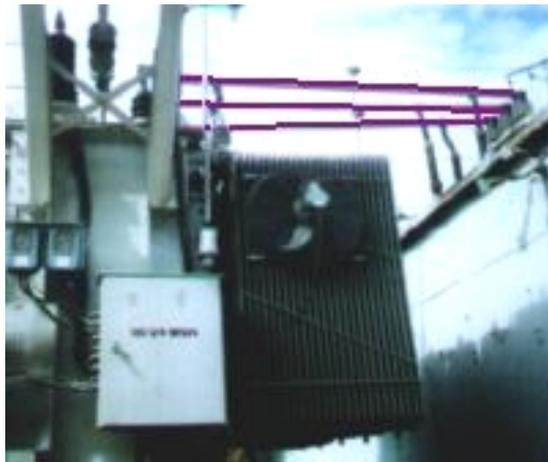
**Figura 3.47:** Barras que van de los pasatapas del lado de 13.8 Kv. del transformador a los aisladores tipo poste ubicados sobre la Metalclad.
