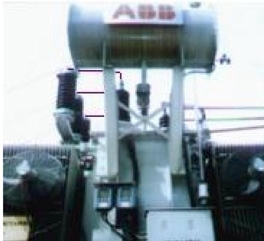
**Figura 3.45:** Barras que van de los pararrayos a los pasatapas del lado de 69 Kv del transformador.
