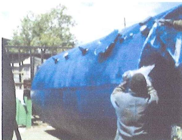
**Figura2.1. Tanque de acero forrado con fibra de vidrio**
