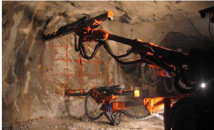
FIGURA 2.8. PERFORACIÓN Y VOLADURA DE UN TÚNEL
