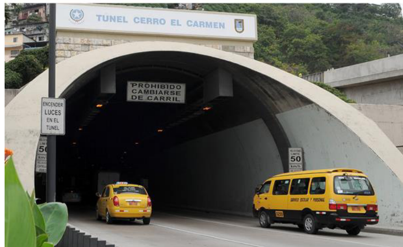
FIGURA 2.1. TÚNEL CERRO EL CARMEN (GUAYAQUIL)
