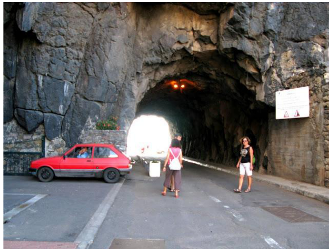
FIGURA 2.3. TÚNEL SIN REVESTIR
