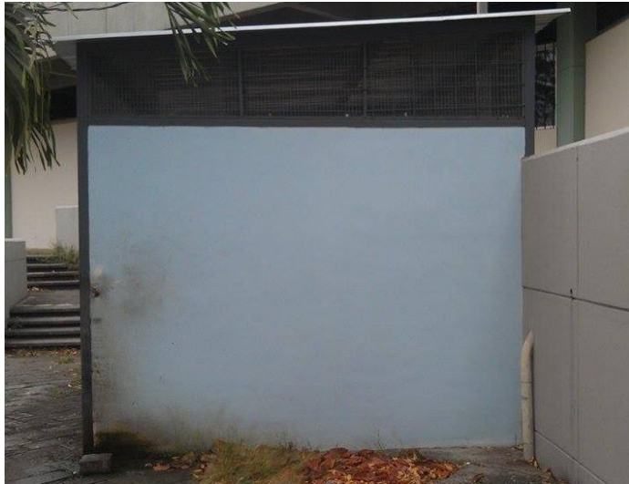
Figura 1.5. Vista lateral de la infraestructura actual
