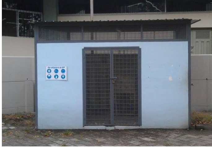
Figura 1.4. Vista frontal de la infraestructura actual
