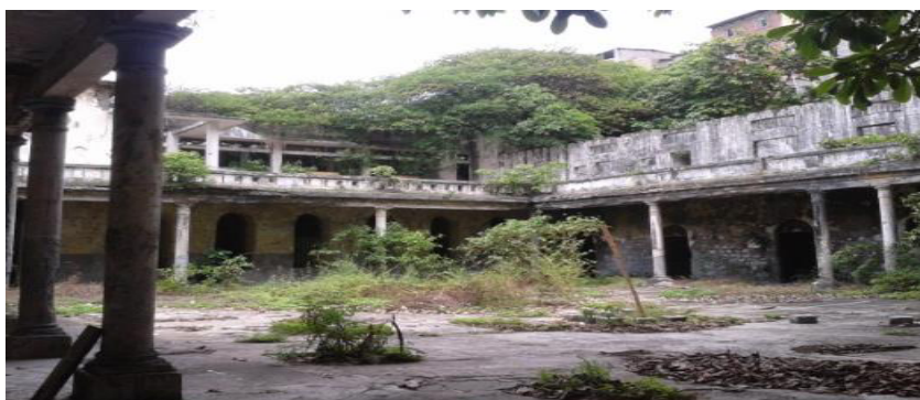
Ilustración 13 Patio interno Antigua Cárcel Municipal
