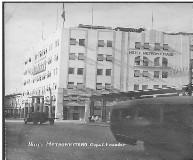
Foto No 2: Edificio del antiguo Hotel Metropolitano
