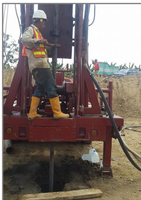
Figura 30: Perforación de un pozo de 10 pulgadas de diámetro.
