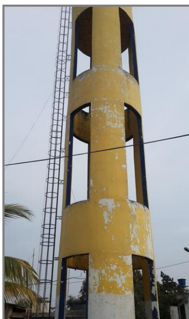
Figura 10: Castillo de 100 m 3 de capacidad, Inicialmente diseñado para una población de 1500 habitantes.
