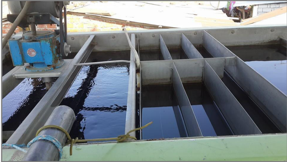
Ingreso del agua cruda proveniente de un pozo de agua subterránea. Inicialmente mezclada con sulfato de aluminio por medio de un agitador mecánico. Posteriormente ingresa a un segundo mezclador hidráulico.
