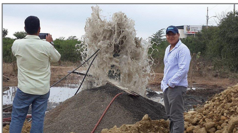
Figura 29: Limpieza y afloración de un pozo de agua terminado de 100 metros de profundidad y 16 pulgadas de diámetro.
