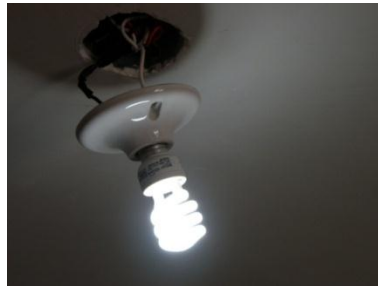
Figura 146. Instalación de un foco.
