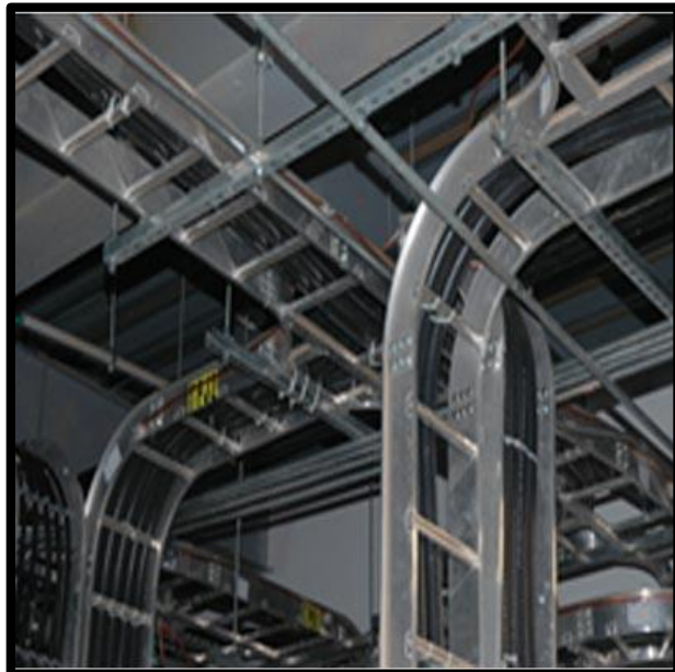
Figura 4.35: Bandejas de Cables.
