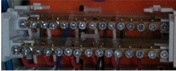
**Figura 4.1 Distribuidor de carga**
