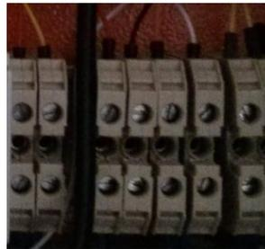
**Figura 4.2 Borneras para cable**
