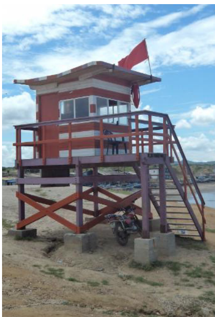
Foto JPG. 3 Torre Salvavidas
