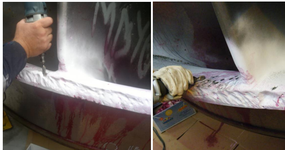
Figura 4.15 Apertura de discontinuidades
