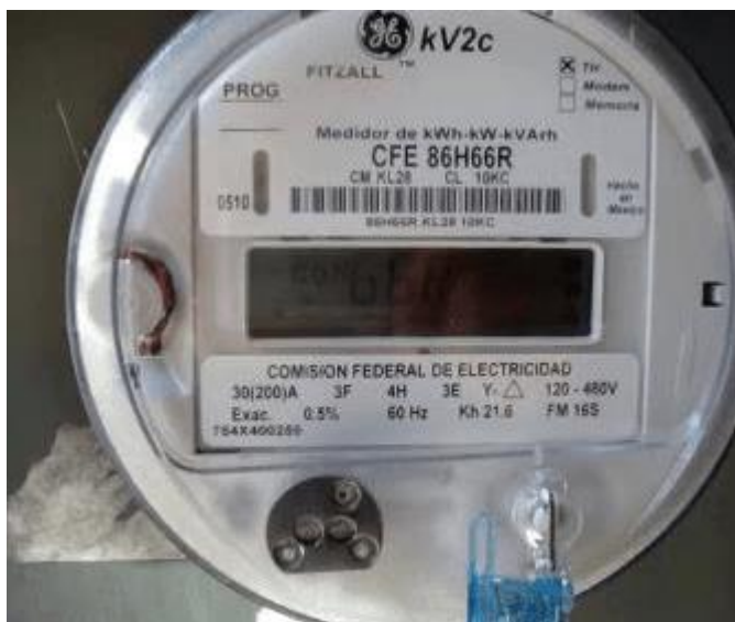
Figura 2. 10 Medidor bidireccional [13]
