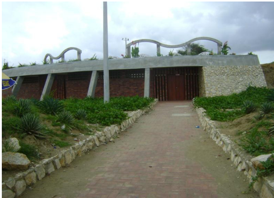
Área de los Baños
