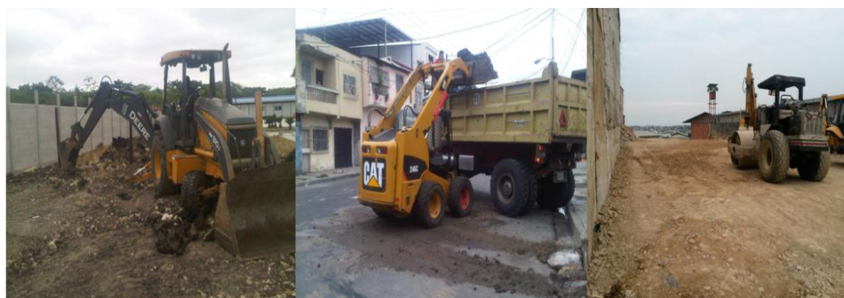
FIGURA 3.2 RETROEXCAVADORA, MINICARGADOR Y RODILLO
