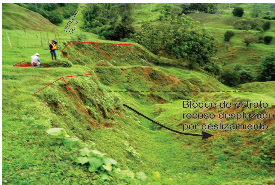
Foto 10. Activos escarpes de deslizamientos para el sitio inestable Pk 61+755 (662.336mE, 10.051.687mN).
