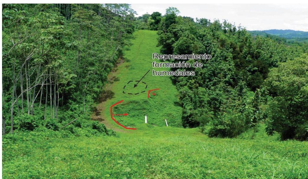
Foto 6. Activo escarpe de deslizamiento para el sitio inestable Pk 56+615 (661.051mE, 10.056.051mN).
