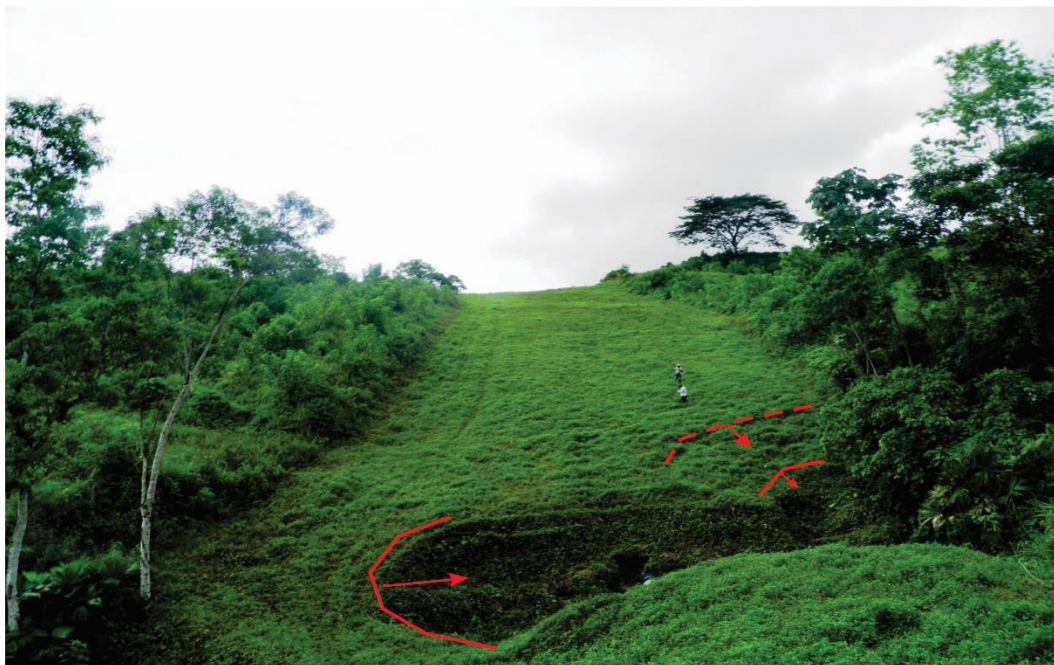
Foto 8. Activos escarpes de deslizamientos para el sitio inestable Pk 57+810 (661.467mE, 10.055.073mN).
