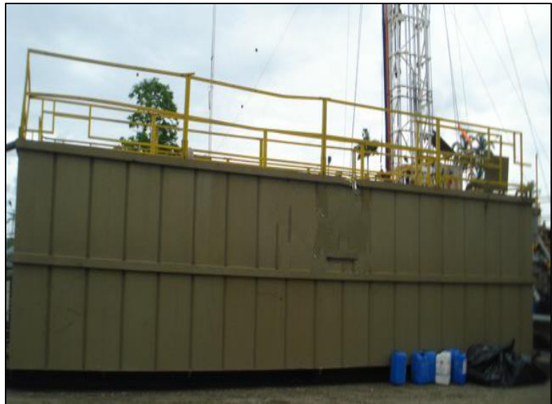
Figura 2.12: Tanques de agua que se empleará para el control del pozo.
