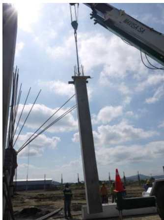
Gráfico 31. Izado de columnas dentro de candeleros (Foto tomada del informe fotográfico de Etinar del 8 de abril al 4 de mayo del 2013)
