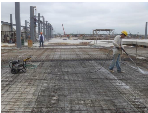
Gráfico 34. Mallas electrosoldadas y limpieza antes de fundición con hormigón premezclado para losas de compresión de los bloques 2 y 4. (Foto tomada del informe fotográfico de Etinar de Agosto del 2013)
