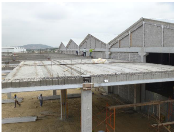
Gráfico 33 Vigas doble t que formaron parte del sistema estructural de la losa de compresión de los bloques 2 y 4. (Foto tomada del informe fotográfico de Etinar del 10 al 22 de junio del 2013)
