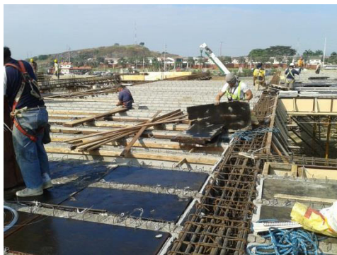
Gráfico 36. Metodología de construcción para losa de compresión del bloque 3. Ubicación de viguetas R-29.(Foto tomada del informe fotográfico de Etinar del 6 de mayo a 1 de junio del 2013)
