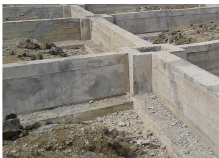
Gráfico 30. Candeleros previstos en la cimentación de los bloques 2, 3, y 4 para colocación de columnas prefabricadas (Foto tomada del informe fotográfico de Etinar de Enero, Febrero, Marzo hasta 6 de Abril del 2013)
