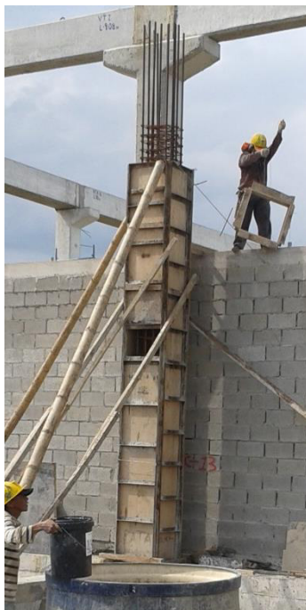
Gráfico 46. Procedimiento constructivo de encofrado de columna para cálculo de cantidad de madera en análisis de costo unitario real de una columna fundida en sitio. (Foto tomada del informe fotográfico de Etinar de Enero, Febrero, Marzo hasta 6 de Abril)
