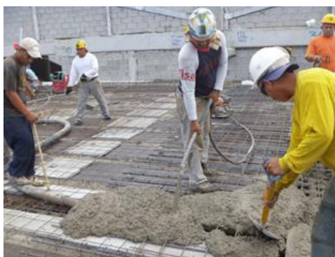
Gráfico 37. Metodología de construcción de la losa de compresión del bloque 3. Malla electrosoldada y fundición con hormigón premezclado. (Foto tomada del informe fotográfico de Etinar del 8 al 27 de julio el 2013)
