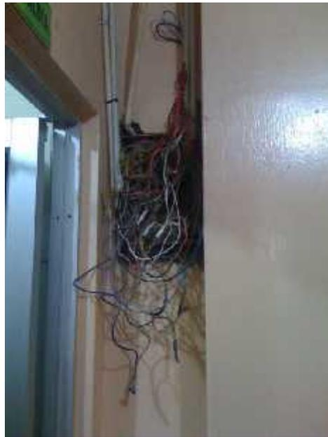
**Ilustración 7 - Tablero eléctrico en mal estado**
