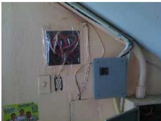
**Ilustración 12 - Conexión eléctrica insegura sin tapa en la planta baja, en la escalera de ingreso al edificio**
