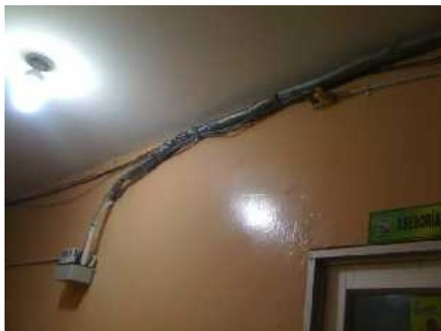
**Ilustración 10 - Cableado eléctrico no cumple con normas de seguridad básicas**
