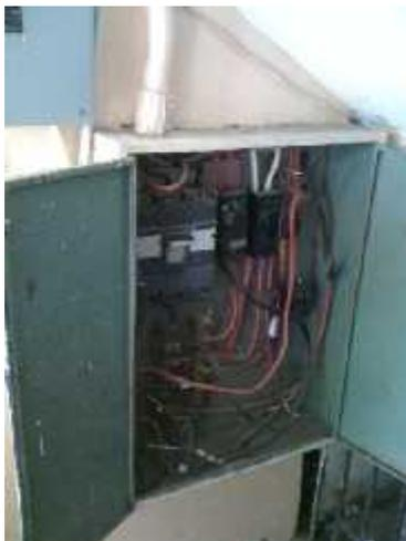
**Ilustración 11 - Tablero eléctrico sin etiquetas de identificación**
