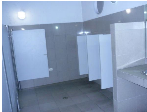
Foto JPG 6: Interior de los baños de hombres.
