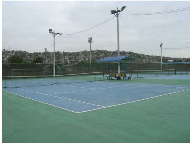
Foto 7: Cancha de tenis de campo
