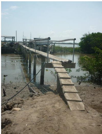
Foto JPG. 1 Puente de Ingreso al Balneario El Playón
