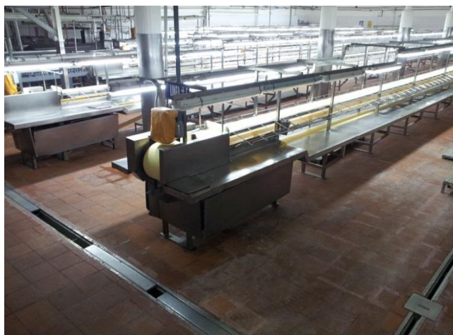
FIGURA 1.7 FOTO REFERENCIAL DE EQUIPOS Y TUBERÍAS SALA DE PROCESO.
