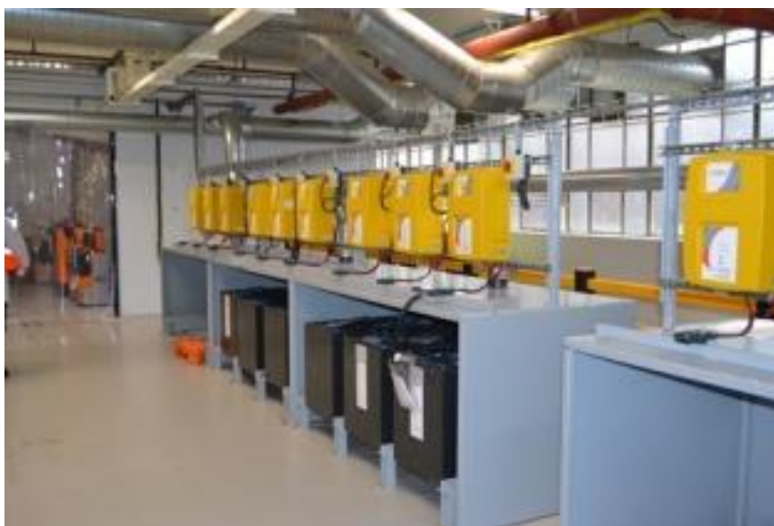
Figura 1.2 Los locales de carga de baterías deben contar con un sistema de ventilación eficiente y seguro.
