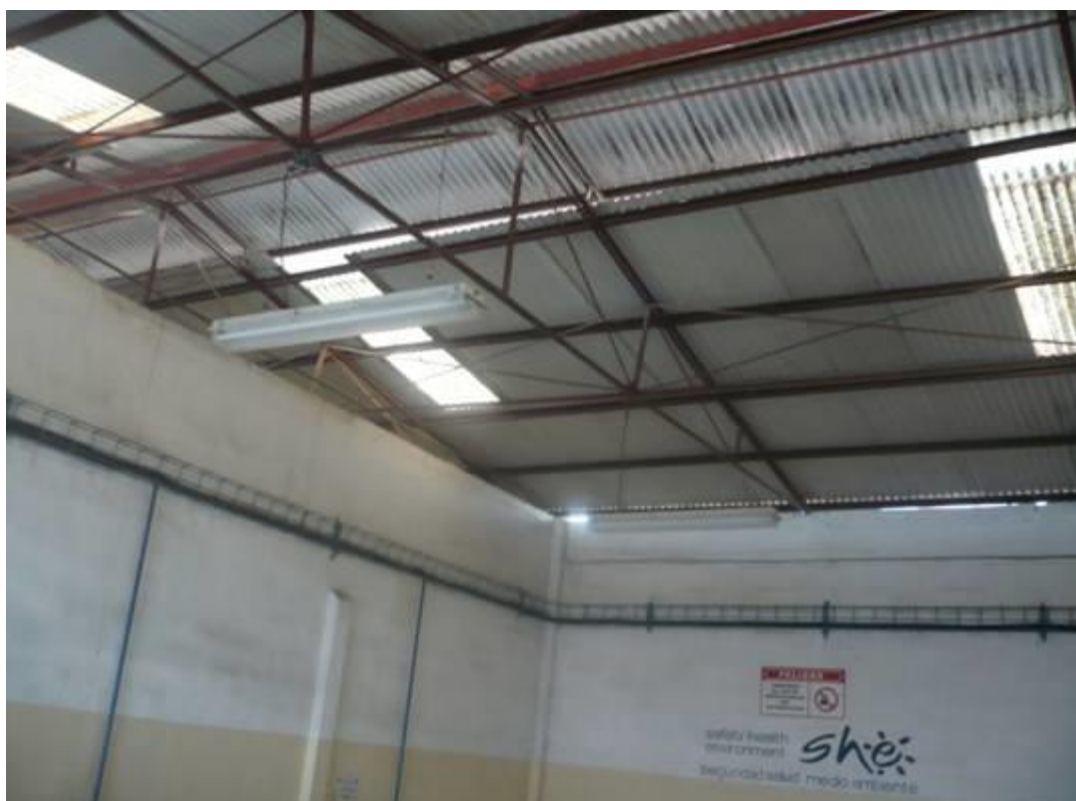
Figura 2.7 Cubierta del área. El traslape del techo permite la salida de aire.
