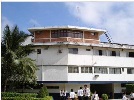
Edificio del pabellón básica superior
