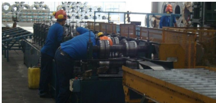
FIGURA 3.4. Equipo de Conformado de Perfiles (PERFILADORA)
