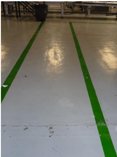
Pintura de piso del sector de máquina y guardas
