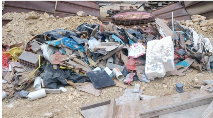
Fotografía2.6: Depósito de materiales sin previa clasificación.
