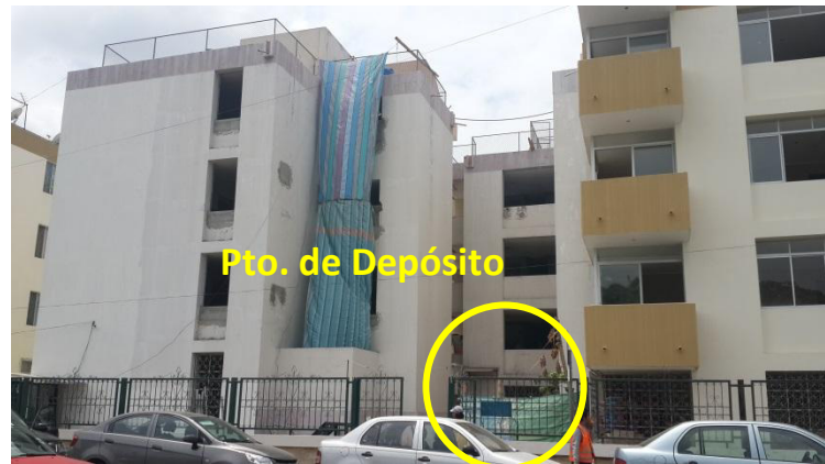
Fotografía 3.3: Punto de depósito de los desechos sólidos en. Obra 1-Remodelación Centenario.
