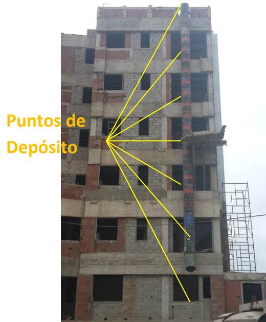
.Fotografía 3.7: Edificio B de la Obra 2-Bosques de la Costa
