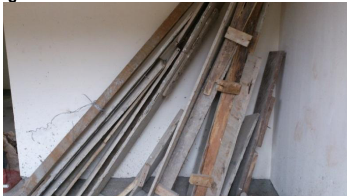
Fotografía 2.1: Madera usada como encofrado en obra.
