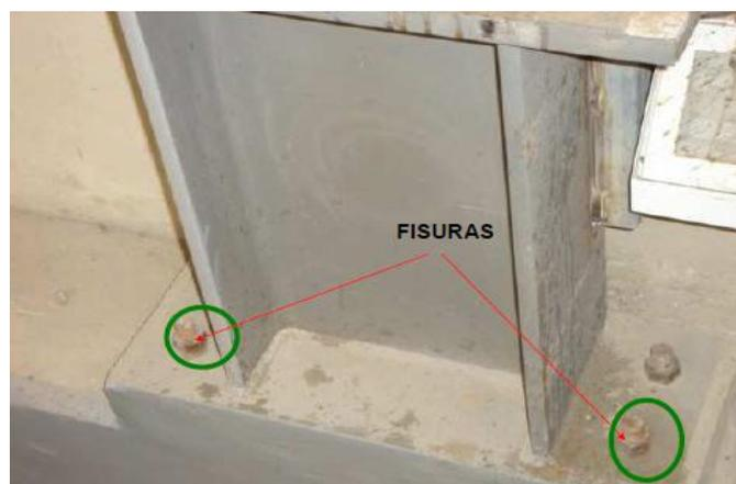
**FIGURA 1.5 CORROSIÓN POR FISURAS**
