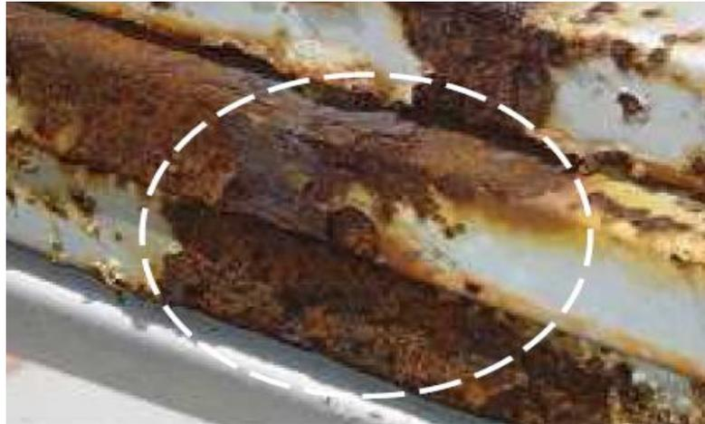
**FIGURA 1.4 CORROSIÓN POR PICADURA**
