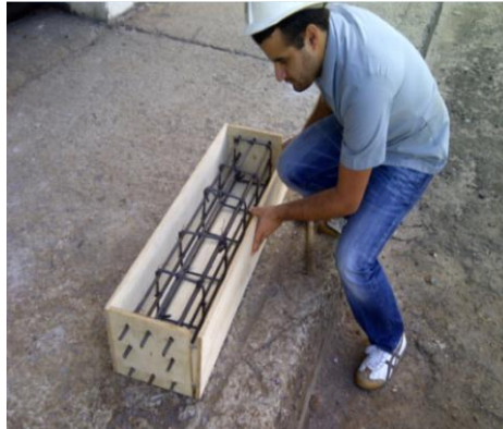
FIGURA 2.10: ESTRUCTURA DE ACERO ARMADO EN SU RESPECTIVO MOLDE DE MADERA.
