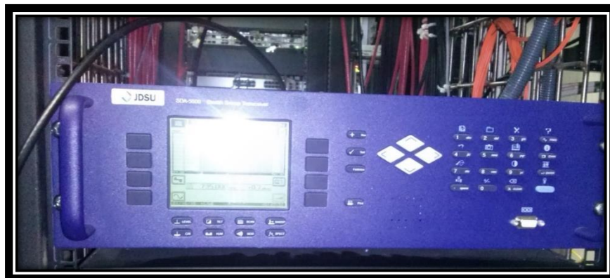
Figura 4. 16. Equipo SDA-5500 (stealth sweep transceiver) el cual está encargado de la medición de salida.
