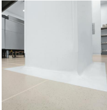
FIGURA 4.2 UNIONES CÓNCAVAS PISOS Y PAREDES
