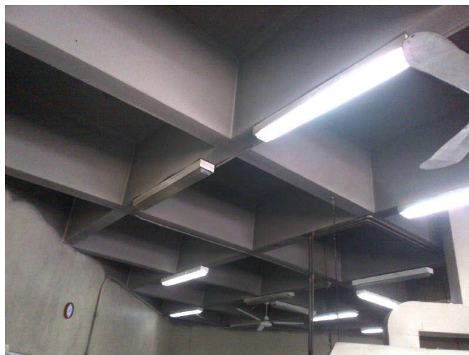
FIGURA 4.4 TECHO DEL COMEDOR ACTUAL
