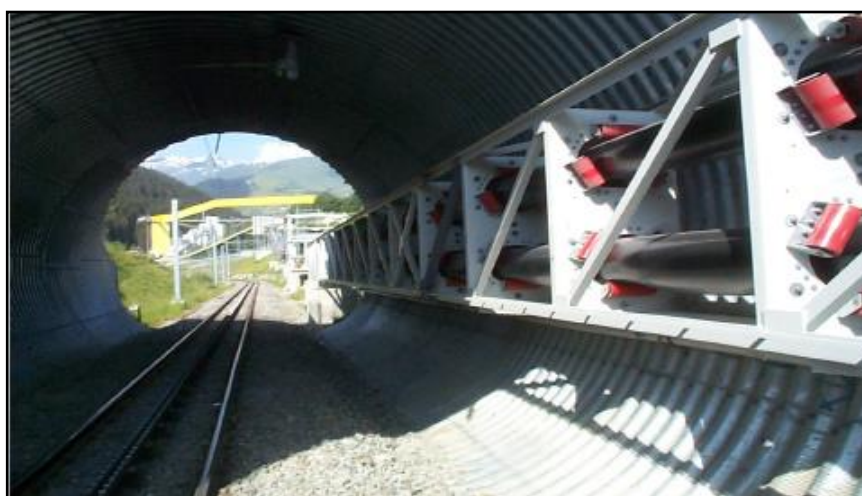
FIGURA 2.7 INSTALACIÓN TÚNEL GOTTHARD SEDRUM SUIZA [13]
