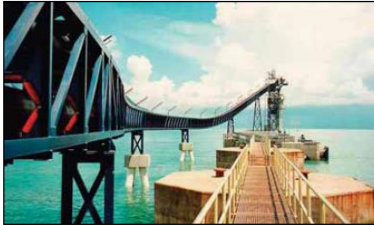
FIGURA 2.2 INSTALACIÓN MALAYAN CEMENT MALASIA [5]
