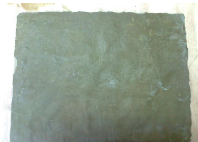
Figura 4.8. Techo S2' con 40% KOH - 12M.
