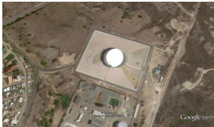
Figura 5. 7. Vista aérea de tanque de techo flotante. Fuente: Google Earth 2015. (Earth, 2007)
