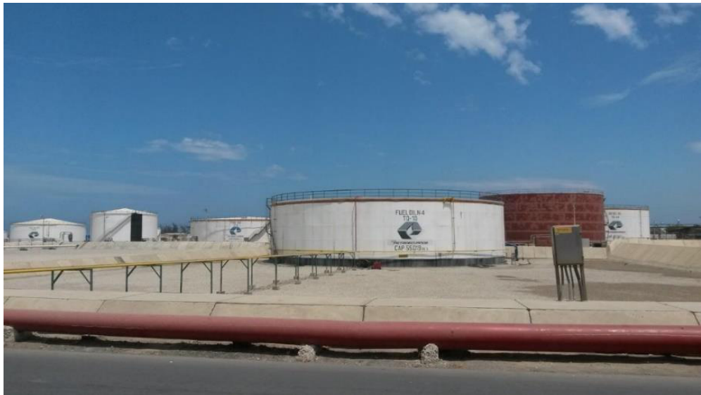
Figura 5. 6. Tanque TQ-10 con techo fijo. Fuente: Foto tomada por los autores.
